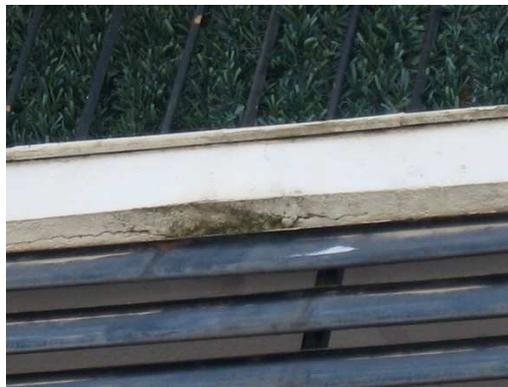
*Figura 16 y 17. Fotografías de humedad en la terraza y formación de moho en el frente del forjado de la terraza. Elaboración propia.*
