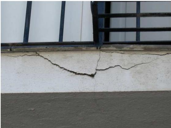
*Figura 12. Fotografía de fisura en frente de forjado en terraza.*
